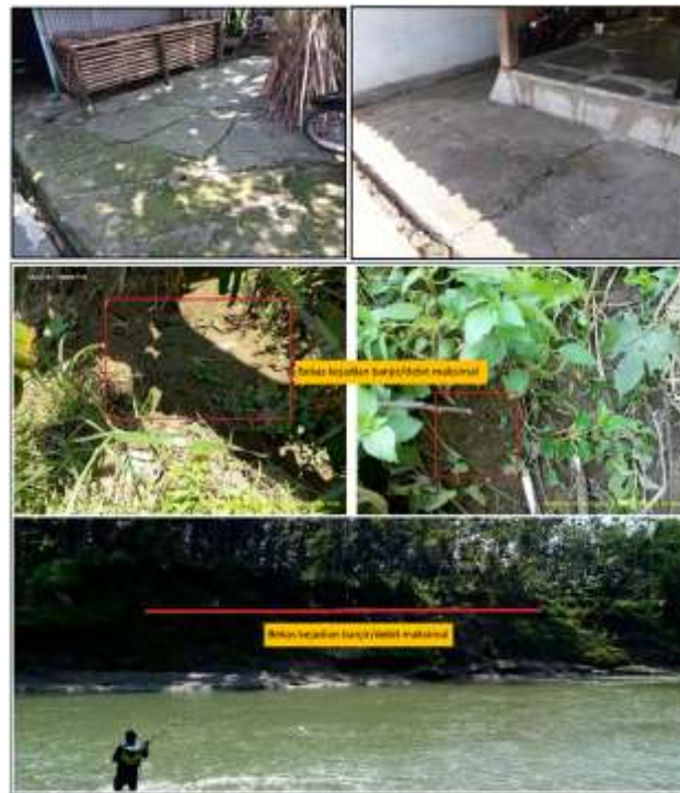
Gambar 3. Kenampakan bekas banjir/debit maksimal dan tanda-tanda keretakan tanah di lokasi kegiatan
