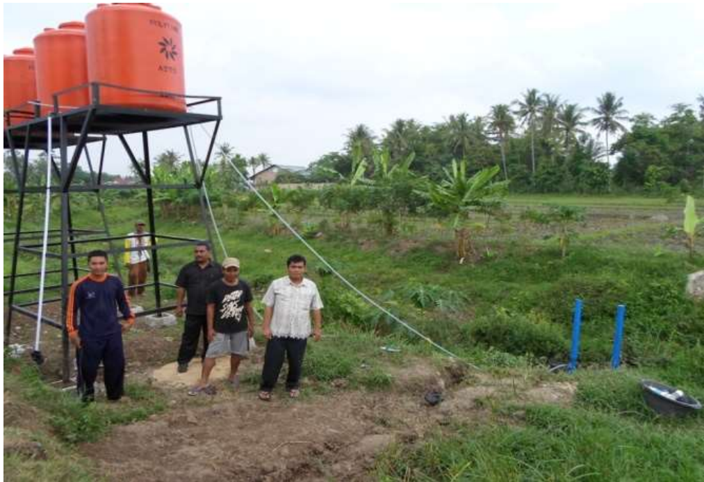
Gambar 5. Hasil pemasangan pompa hydram untuk model sistem irigasi
