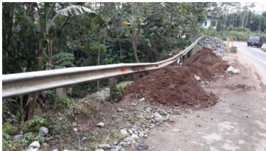
Gambar 1. Longsor yang terjadi di jalan lintas barat Desa Batu Keramat, Tanggamus
