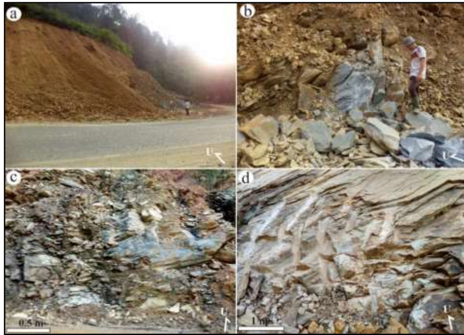
Gambar 3. Beberapa lokasi gerakan massa di sepanjang jalan Muara Emat - Kerinci, a) gerakan tanah dan batuan meta batupasir, b) gerakan tanah dan batuan filit, pada batuan filik membentuk bongkahan-bongkahan sebagai akibat dari penekaran, c) gerakan massa batuan filit yang memperlihatkan adanya zona hancuran dari suatu bidang sesar, d) gerakan massa batuan slet - filit dengan kemiringan bidang foliasi yang hampir sejajar dengan bidang perlapisan, indikasi sesar berupa zona hancuran
