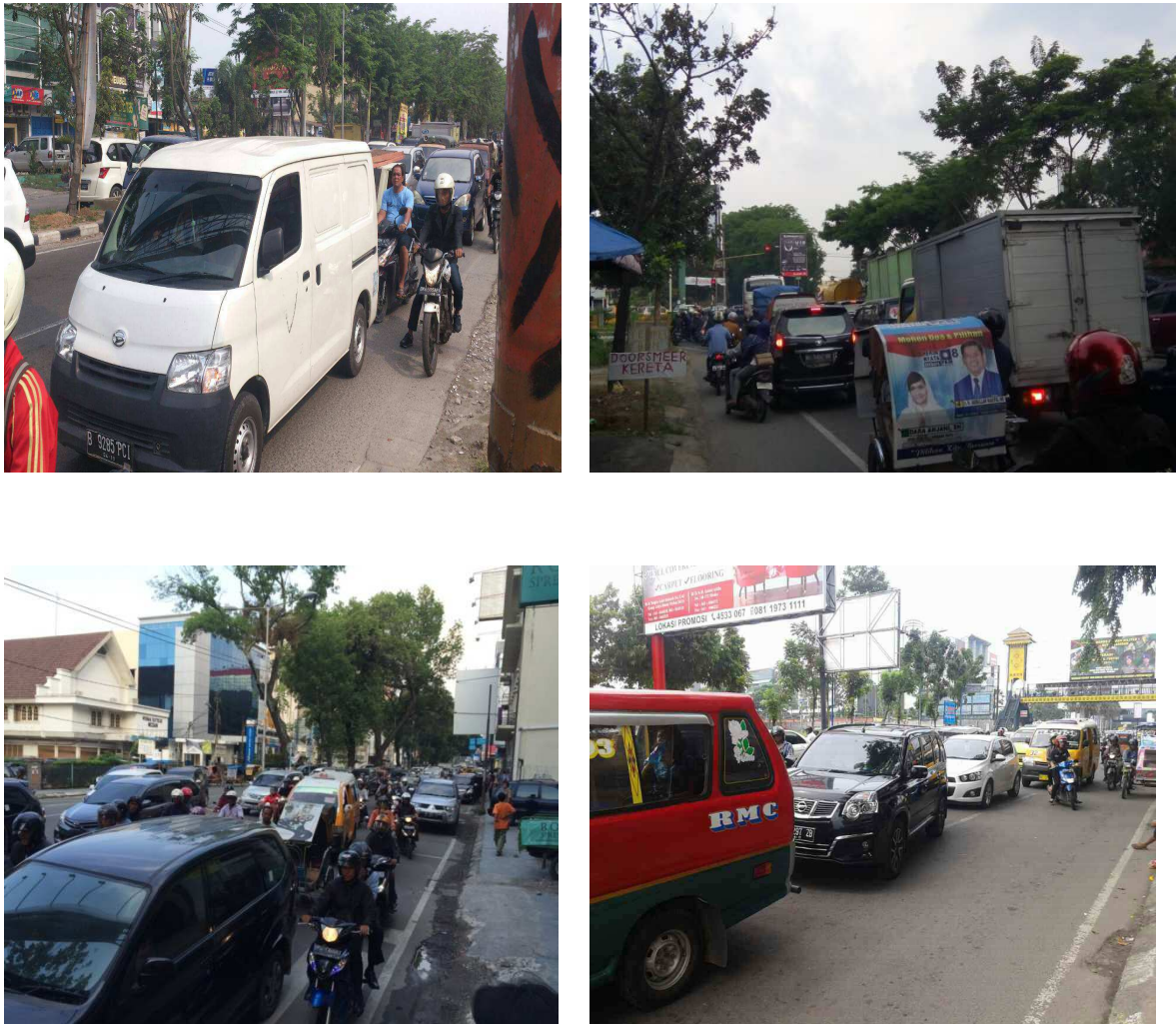
Gambar 1. Kondisi Jalan Eksisting dalam Rute Rencana Pembangunan Monorel
